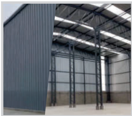
OBRA: Almacén General
