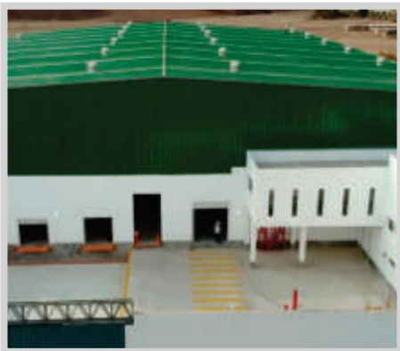
OBRA: Almacén Pulmon Ardiles Import
