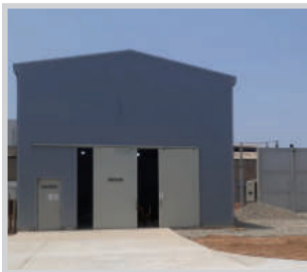
OBRA: Construccion Set Progreso - Luz del sur
